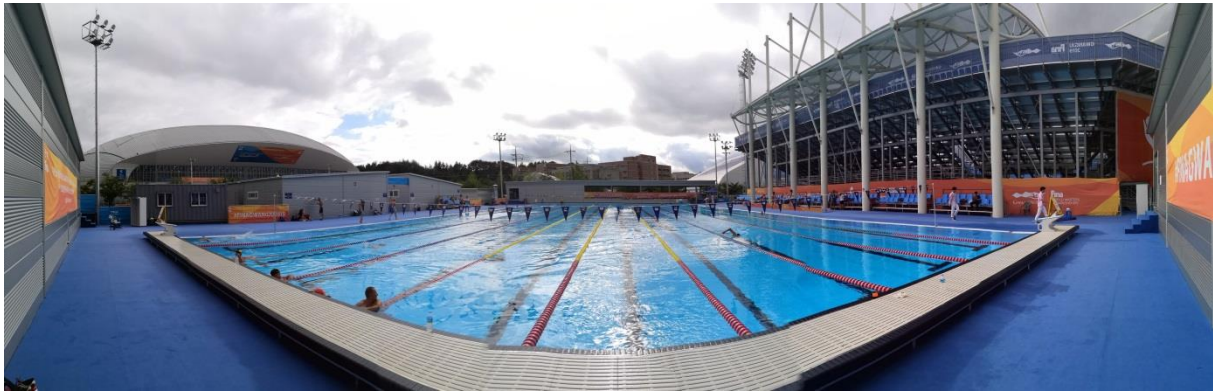
Outdoor-Becken für Ein- und Ausschwimmen (links im Bild ist die Schwimmarena, rechts Wasserball-Stadion)
